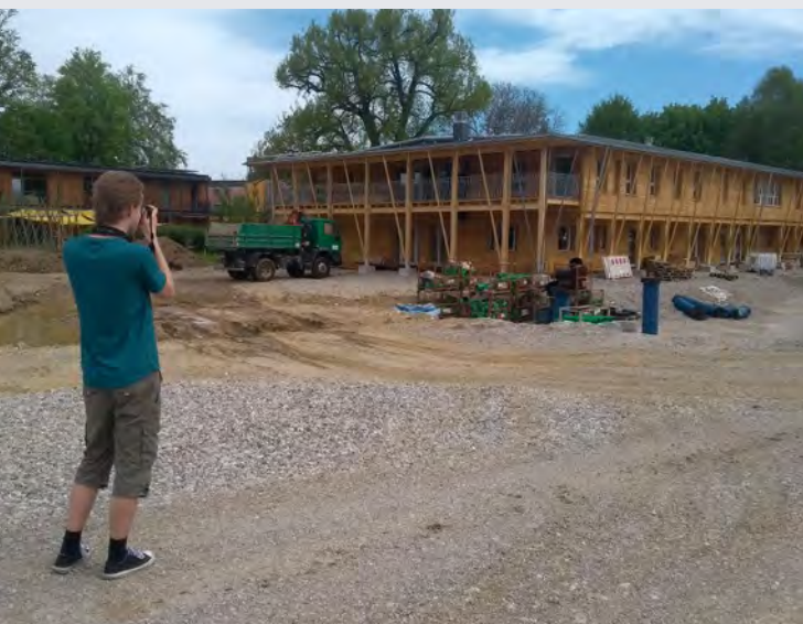
Julian auf der Baustelle
